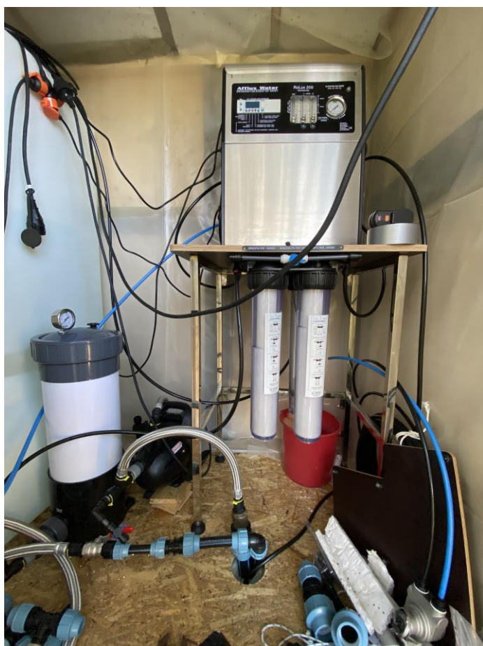
Pågående installation av avsaltningsanläggning.
